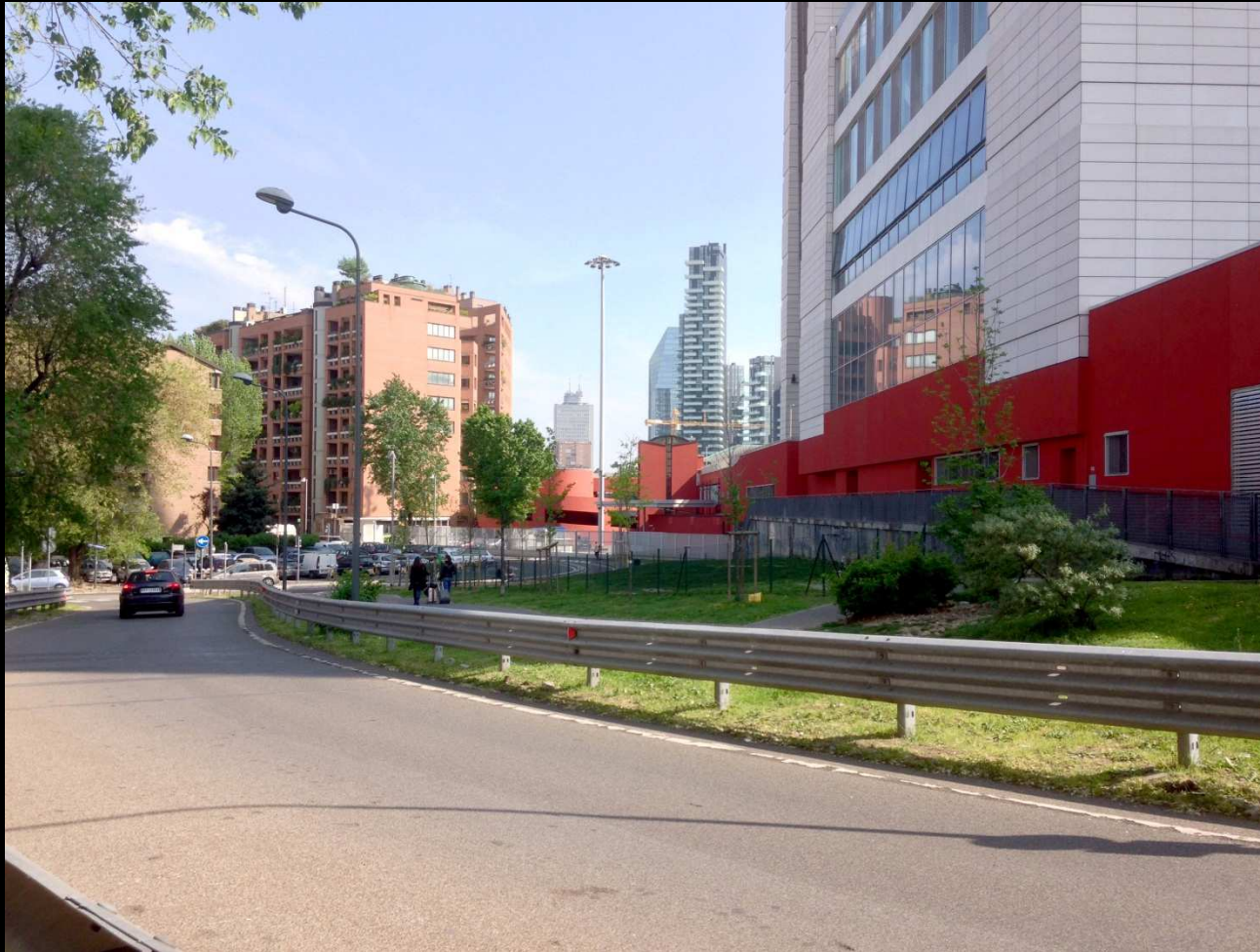
Cavalcavia Bussa: Vista della rampa verso Via De Castilia
