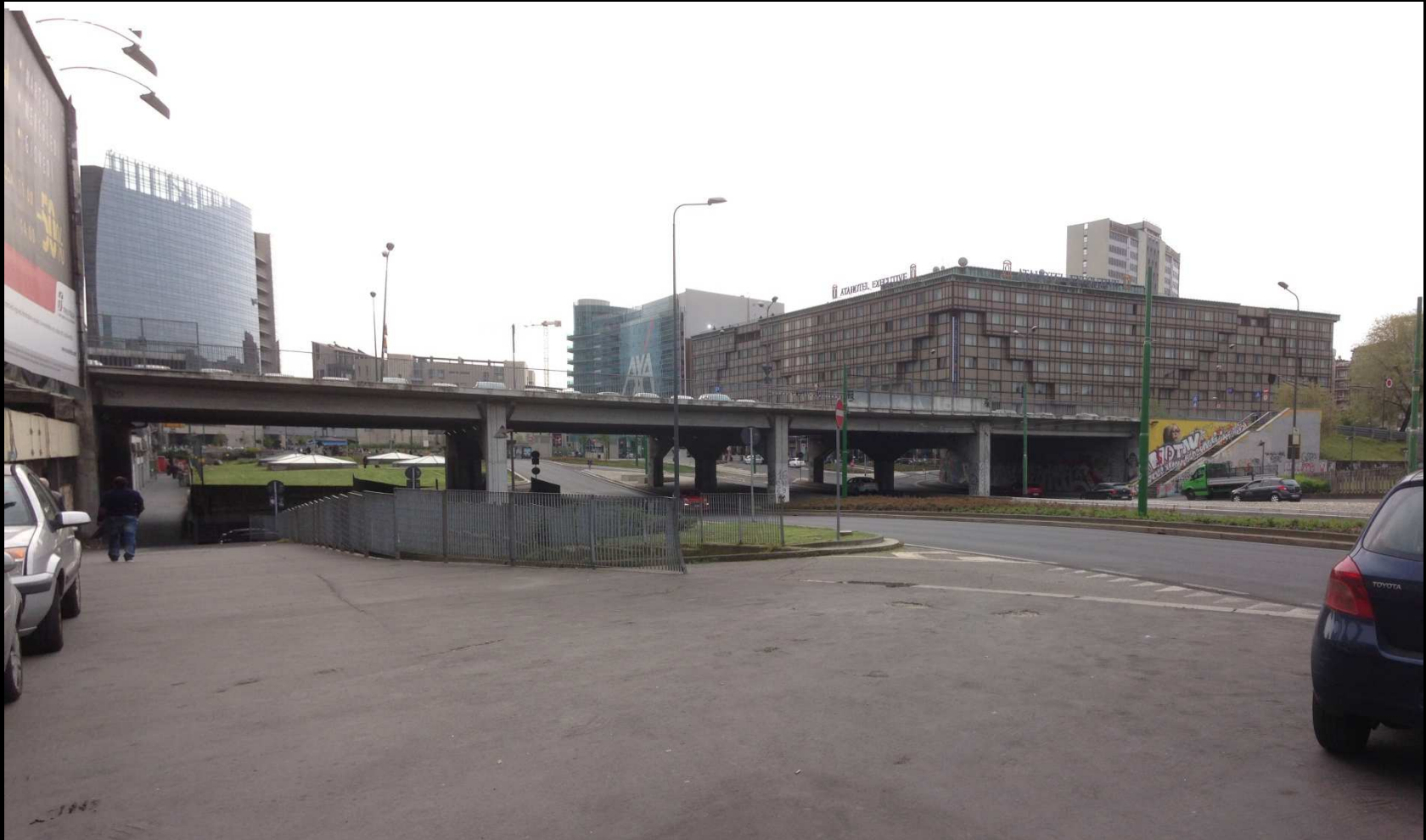
Cavalcavia Bussa: Vista del Cavalcavia da Nord
