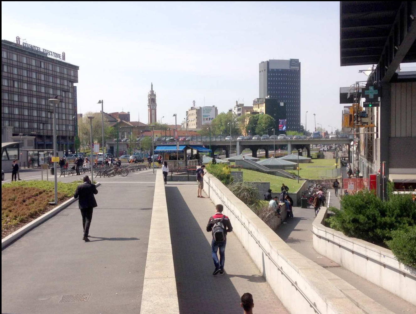
Cavalcavia Bussa: Vista delle rampe e delle scale verso piazza Freud
