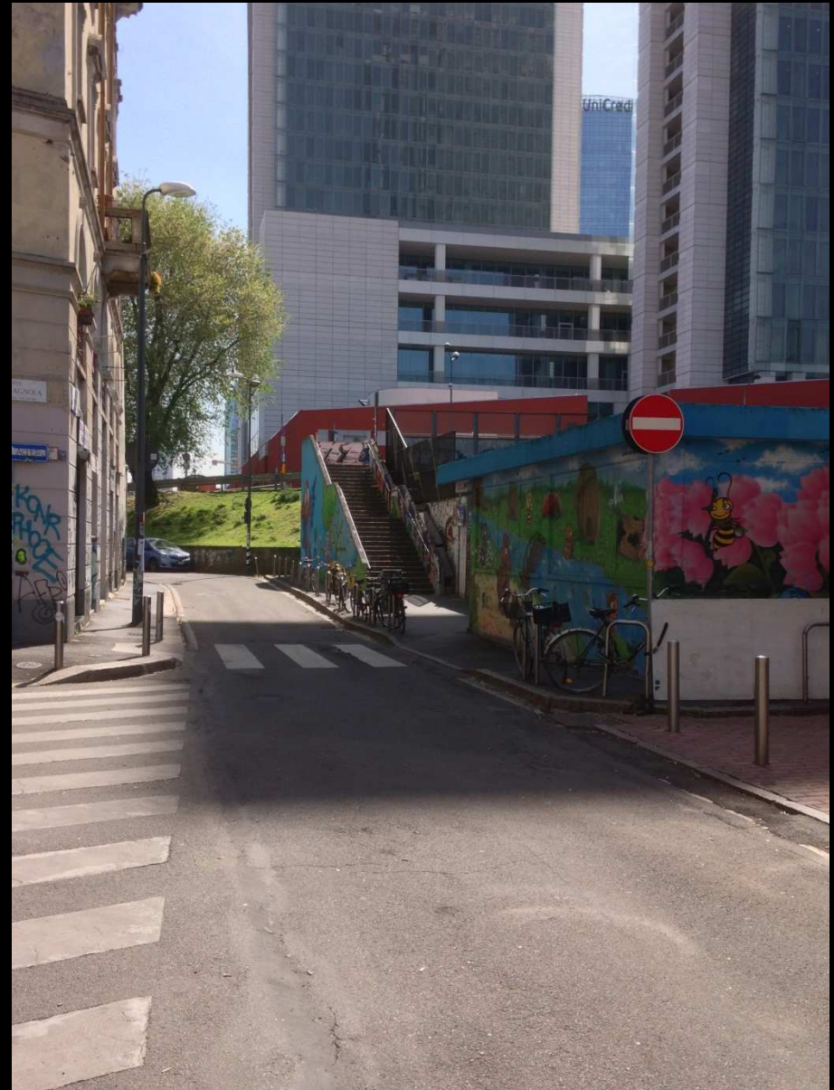
Cavalcavia Bussa: Vista scala e sottopasso per la Stazione
