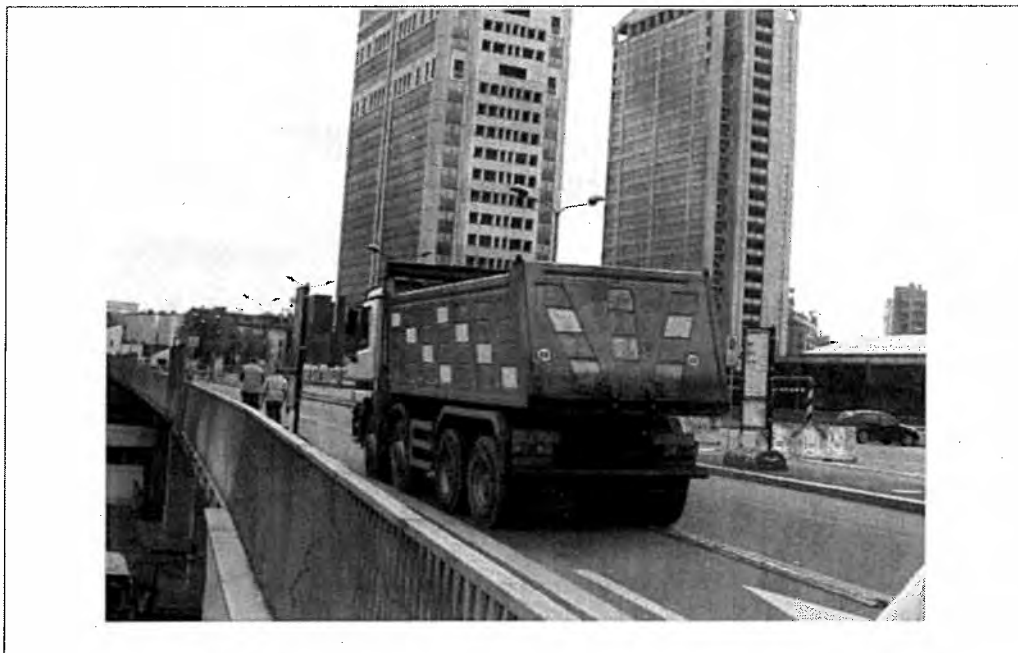
Allestimento carico 1° step
